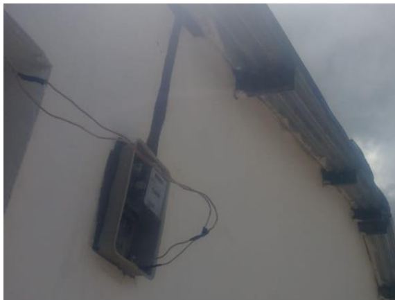
Foto 5. Instalación de acometida eléctrica
