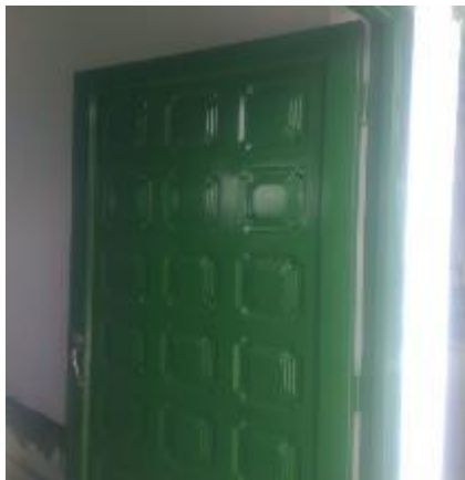
Foto 3. Pintura en carpintería metálica
