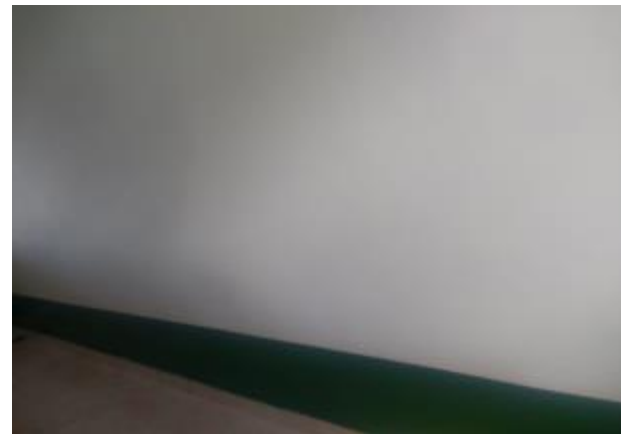
Foto 4. Pintura interior en aulas de clase
