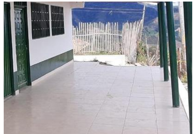
Foto 6. Enchape de piso en corredor.
