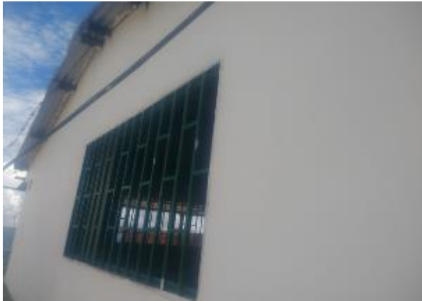
Foto 1. Pintura exterior en muros
