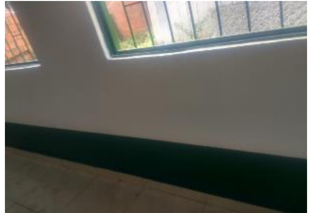
Foto 2. Reposición de zócalo interno en aulas de clase
